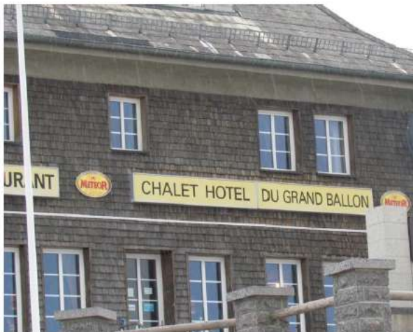
Le chalet-hôtel du Grand-Ballon se met en conformité avec la réglementation sur l'accueil des personnes à mobilité réduite. PHOTOS DNA - GREGOIRE GAUCHET
